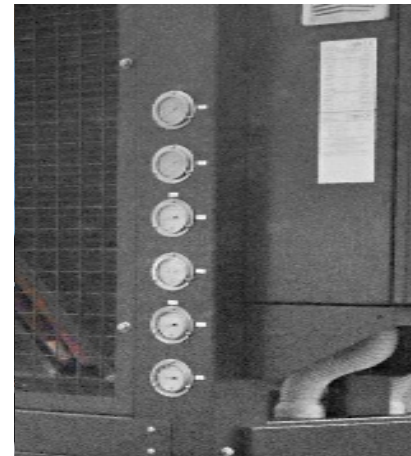
Manometri gas refrigerante, alta e bassa pressione manometrica Refrigerant manometers, high and low pressure gauges.
